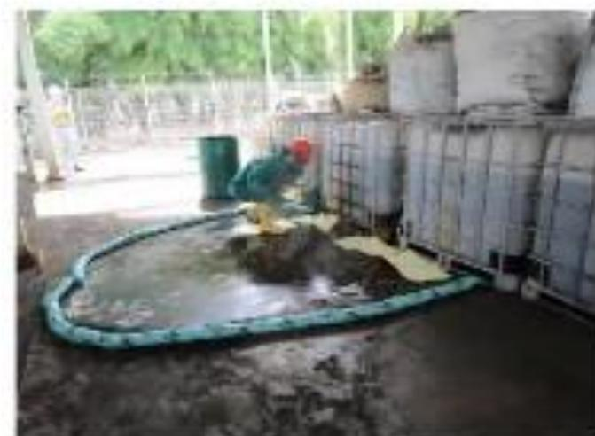
Gambar 3: Penanganan Tumpahan *Chemical* Dengan *Universal Spill*
