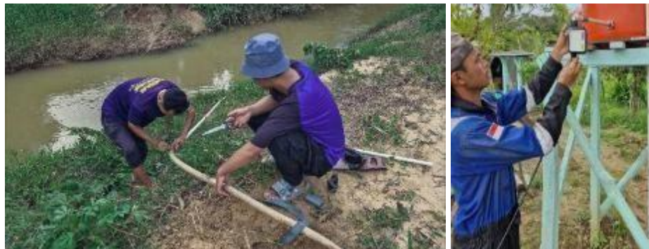
Gambar 5. Pemasangan jaringan pipa dan koneksi ke tandon air
