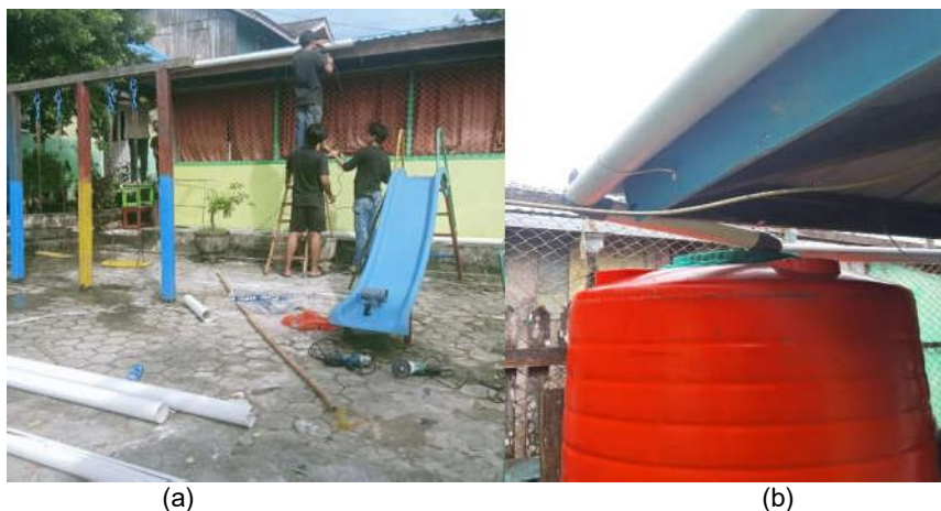
Gambar 2. (a) Pemasangan talang air dan (b) hasil pemasangan talang air serta tandon
