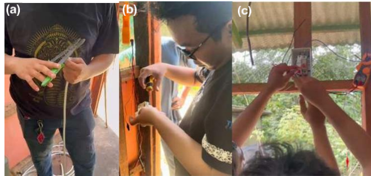
Gambar 10. Perbaikan Instalasi Listrik meliputi Pergantian Kabel (a), Perbaikan Saklar (b) dan Pengecekan Arus (c)
