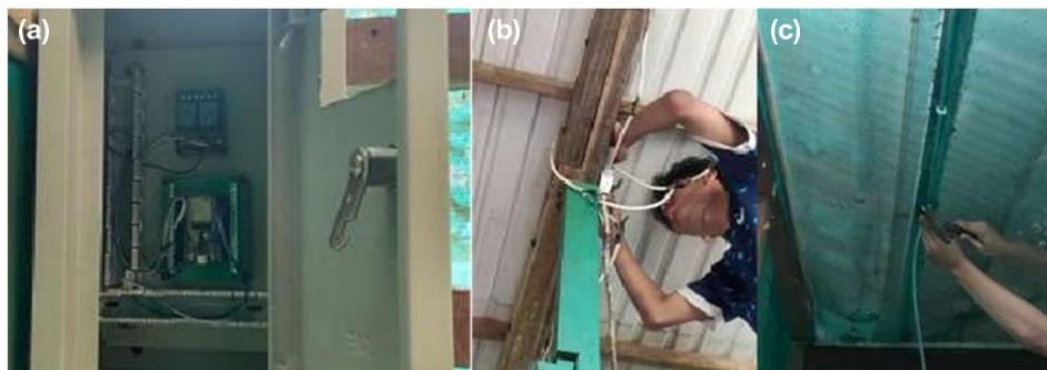
Gambar 11. Pembuatan Alat Pengatur Suhu meliputi Perakitan Sistem Sensor (a), Pemasangan Relay Lampu (b) dan Penyiraman (c)
