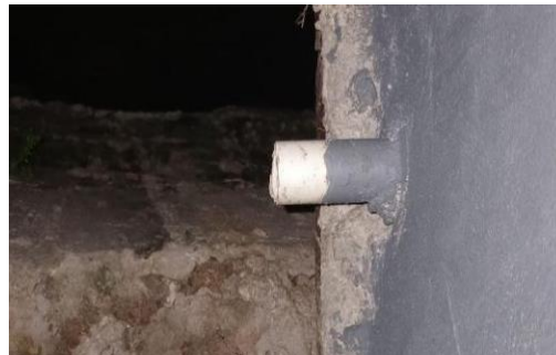
Gambar 4. Bentuk Pipa yang Berperan sebagai Drying System
