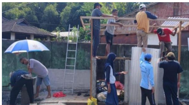
Gambar 5. Pemasangan Atap PVC Transparan Sebagai Drying System
