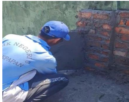
Gambar 3. Proses Pengecoran dan Pemasangan Batu Bata
