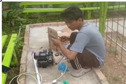
Gambar 6. Pemasangan Pompa Air
