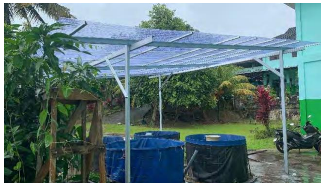
Gambar 2. Hasil pemasangan atap pelindung pada kolam ikan di Panti Asuhan Putri Aisyiyah
