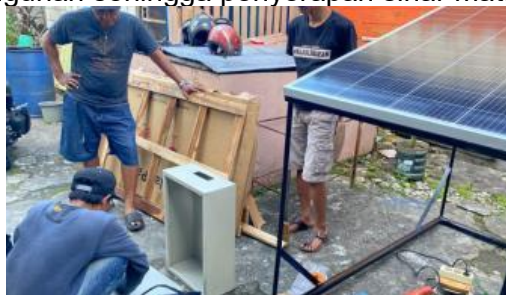
Gambar 4 Pemasangan Panel Surya ke Rangka
