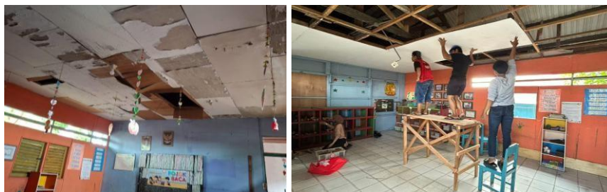
Gambar 5. Kondisi Platfon Ruang Kelas Sebelum dan Sesudah Diperbaiki
