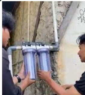
Gambar 3. Pemasangan Filter Air
