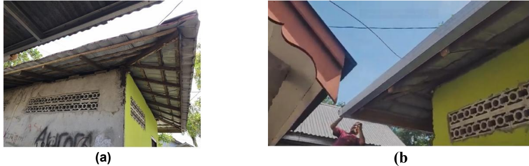
Gambar 4. Kondisi Penadah Air Hujan (a) Sebelum Ditambah (b) Setelah Ditambah
