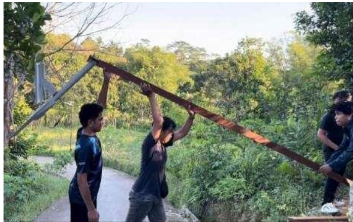
Gambar 3.6 Pendirian Tiang Utama PJUTS Sumber : Penulis,2025
