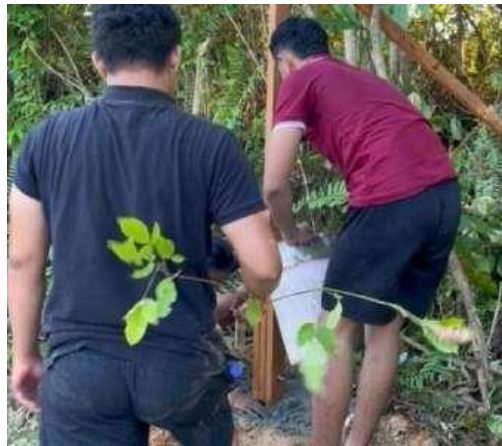
Gambar 3.4 Pemasangan Tiang Pondasi PJUTS Sumber : Penulis,2025
