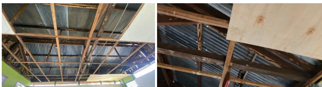
Gambar 4. Pembongkaran Plafon
