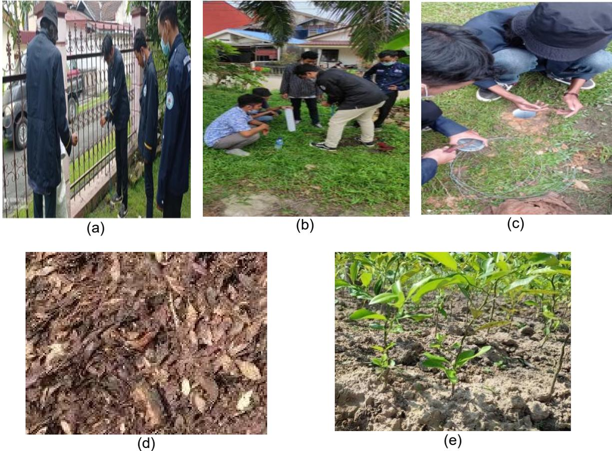
**Gambar 2. Instalasi LRB (a) Pengeboran tanah; (b) Pemasangan pipa PVC ke dalam tanah; (c) Pemasangan kawat untuk penutup lubang berongga; (d) Kompos hasil LRB; (e) Pemanfaatan kompos pada tanaman warga**
