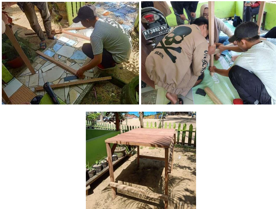
Gambar 5. Pembuatan meja alat desalinasi
