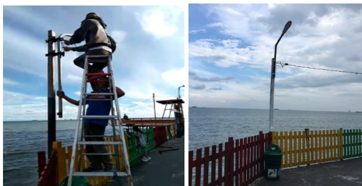
Gambar 4. Proses Pemasangan PJU
