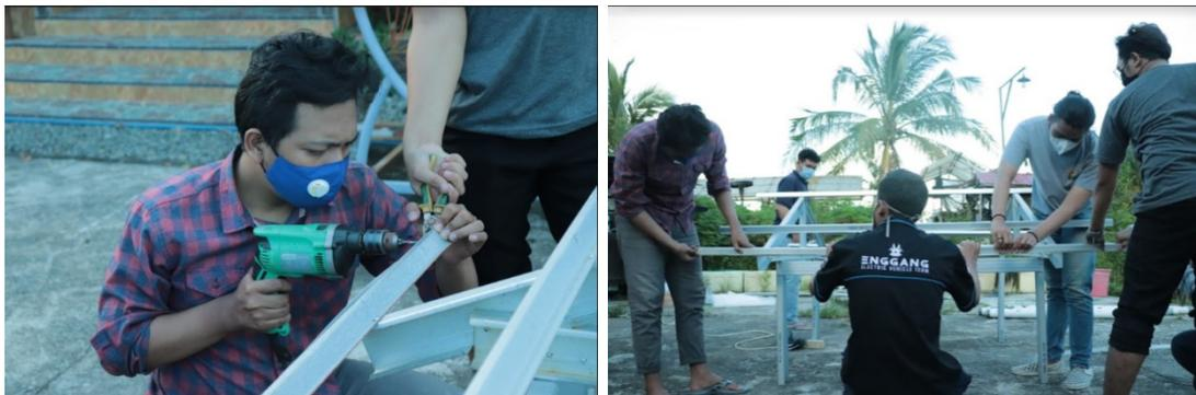
Gambar 1. Pemasangan rangka dengan menggunakan baja ringan
