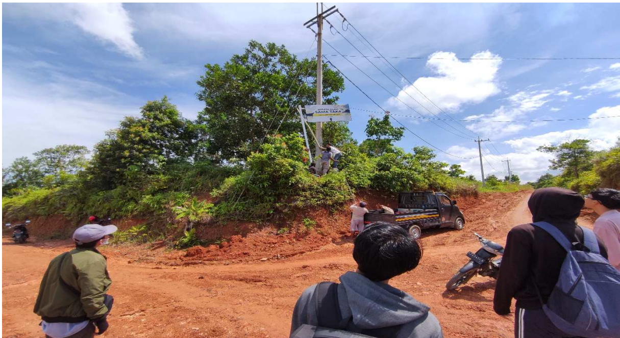
Gambar 5. Pemasangan Papan Nama dan Penunjuk Jalan di Simpang Empat Jalan Masuk Salok Lay
