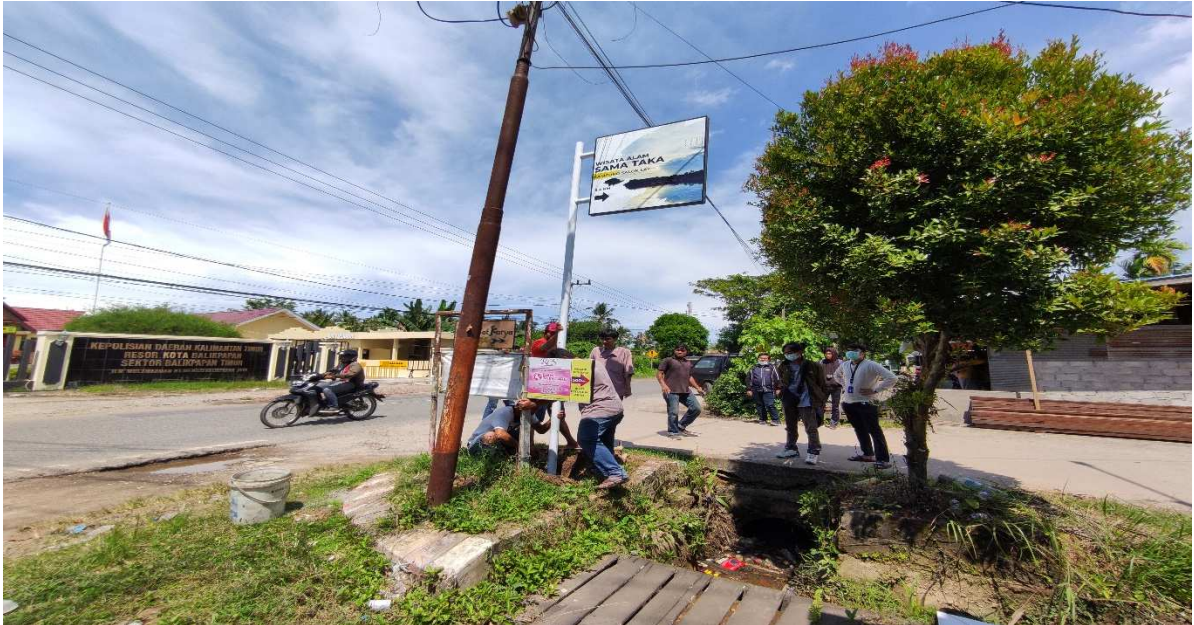
Gambar 4. Pemasangan Papan Nama dan Penunjuk Jalan di Depan Polsek Lamaru
