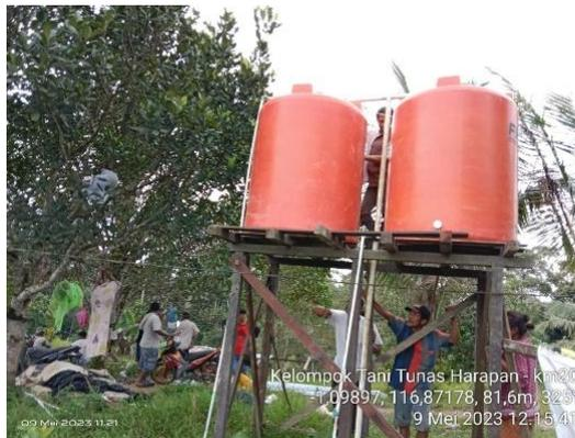
**Gambar 10.** Menara tandon air dengan kapasitas 2 x 1200 liter
