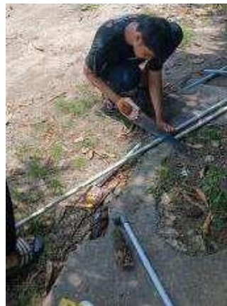
Gambar 4. Pemotongan Pipa Sprinkler
