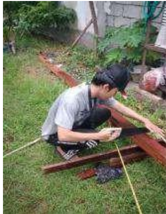
Gambar 1. Pengukuran dan Pemotongan Kayu Penyangga Pompa
