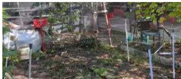
Gambar 5. Instalasi Rakitan Pipa Sprinkler
