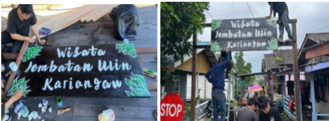
Gambar 6. Proses Pembangunan Gapura Wisata Jembatan Ulin Kariangau
