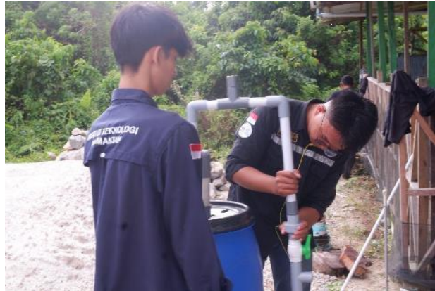
Gambar 7. Proses Instalasi Sistem Filtrasi
