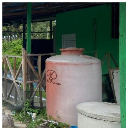
Gambar 2. Kondisi Tandon Penampungan Air Hujan Masjid Baitussalam
