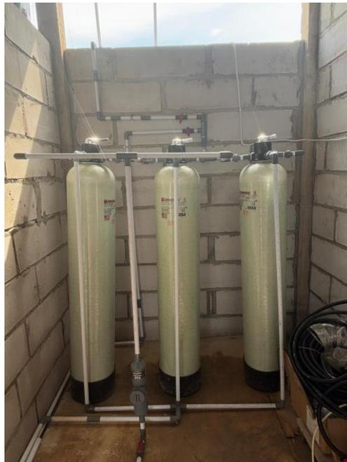
**Gambar 9. Penempatan *Filter Tank***
