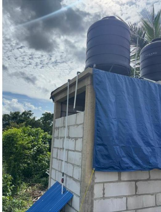
**Gambar 8. Pompa Menarik Air Sungai Menuju Tandon Air Kotor**
