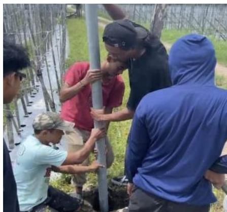
**Gambar 7.** Pemasangan Tiang PJU TS (Contoh pemasangan tiang pada satu diantara empat titik)
