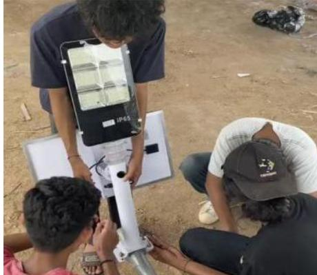
**Gambar 8.** Lampu PJU-TS (Tampak lampu LED dan Panel)
