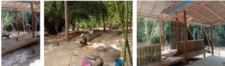
**Gambar 9. Pembangunan lantai kayu dan dinding bambu**
